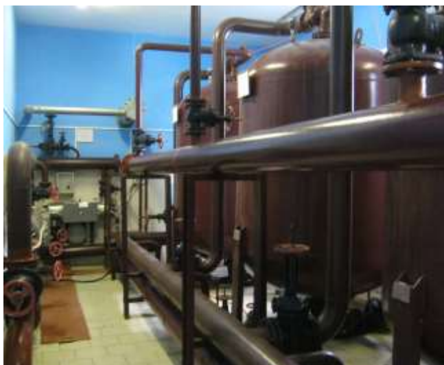
Станция обезжелезивания г. Островец
